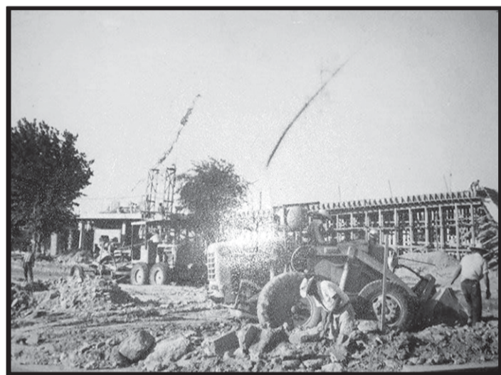
En 1964, Después de haber demolido los edificios más antiguos y hermosos de la ciudad se levanta nuevas construcciones, utilizando únicamente concreto.
